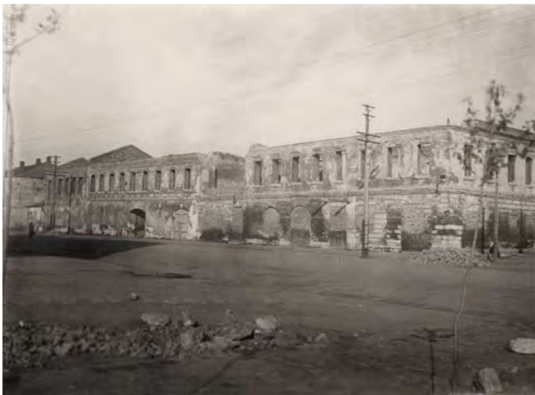
Дом по улице Красной в г. Михайлове, разрушенный в период оккупации. 1941 (№ 243)
